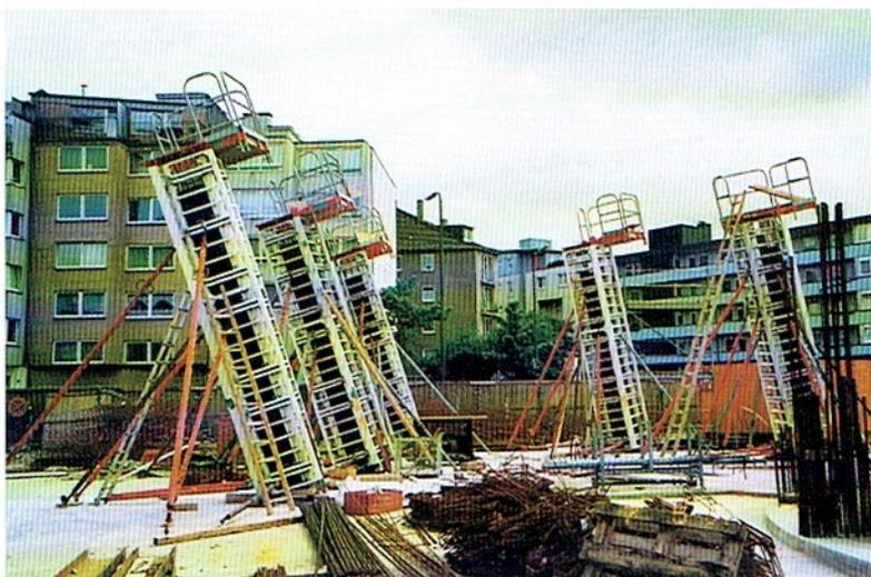
Bild 22: Schalung und Abstützen für die schrägen Stützen
