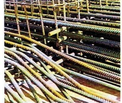
Bild 17: Mehrschichtige Bewehrung der Tiefgaragendecke
