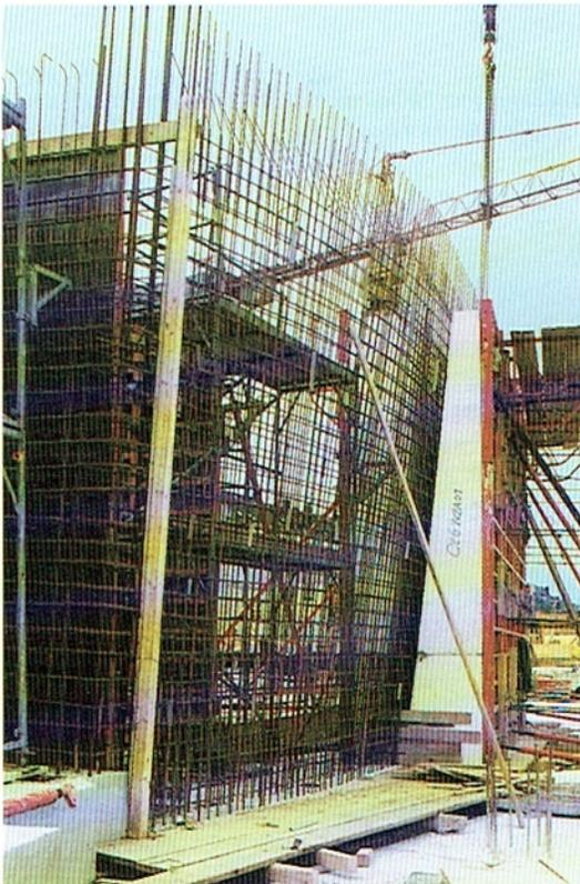
Bild 42: Einbau der Bewehrung von Styroporinlets
