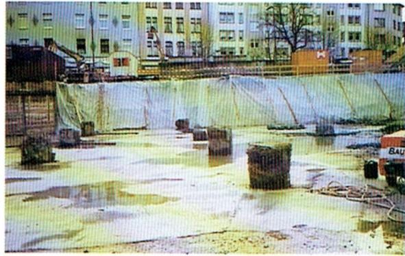
Einige dieser Pfähle wurden so ausgebildet, daß sie bei Eintritt des Lastfalls Hochwasser auch als Zugpfähle zur Auftriebsicherung dienen. Zusätzlich wurden noch vorhandene Gründungspfähle der ehemals auf dem Grundstück befindlichen Speichergebäude in die Lastabtragung integriert.
