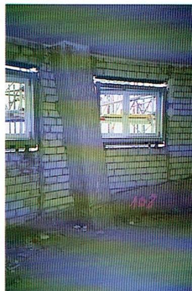
Bild 20: Fast alle Stützen sind schräg! Quadratisch in Haus A (links) und Haus C (rechts), rund in Haus B (Mitte)
