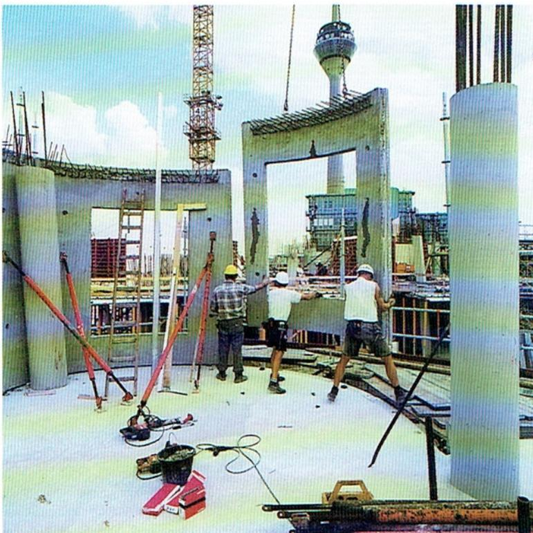
Bild 36: Einbau der Fertigteile in die Fassade von Haus B
