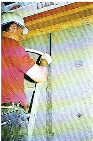
Bild 30: Verfüllen von Fugen zwischen den Fertigteilen mit thixotropem Mörtel
