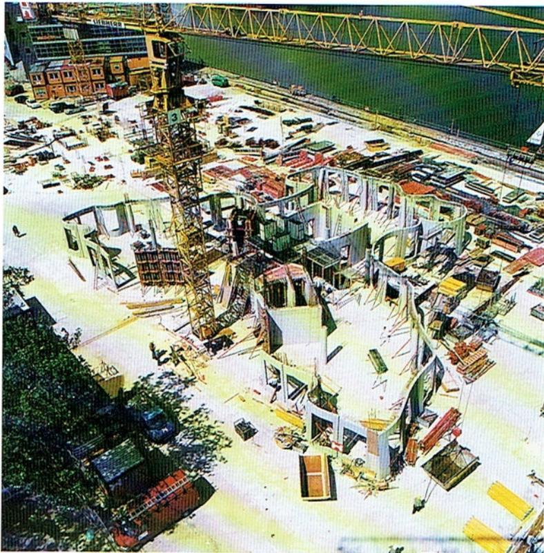
*Bild 38: Paßgenauer Einbau der Fertigteile auf der vor Ort betonierten Betonplatte für Haus B*
