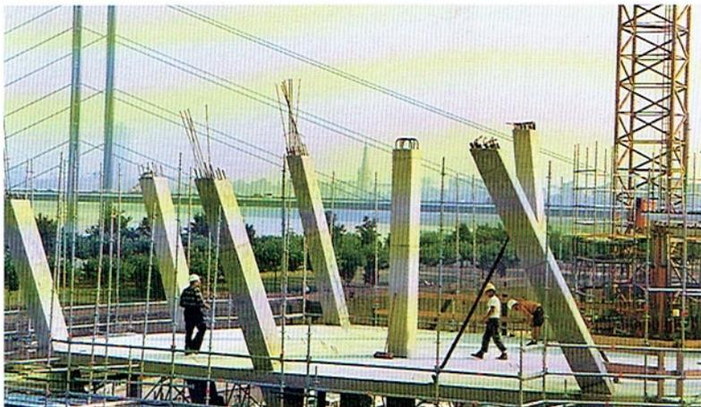
Bild 21: Bis zu 28° geneigte Stützen im 2. Obergeschoß von Haus C
