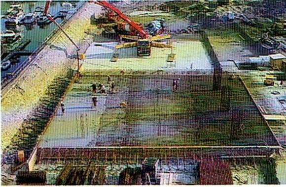
Bild 7: Betonieren der Sohle
